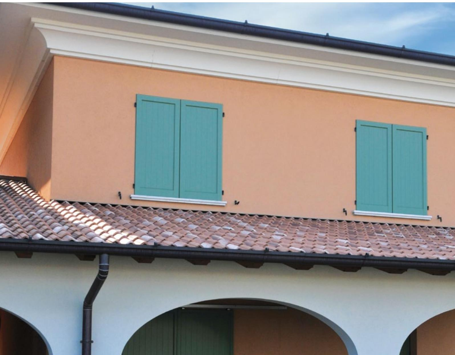
Realizzato con struttura perimetrale a vista internamente ed esternamente lo scuro modello NERINA si caratterizza con una cornice con rotondità accentuata disposta lungo il perimetro centrale nella quale si incastonano perfettamente le doghe verticali tipiche degli scuri lombardi; tale cornice evidenzia maggiormente la differenza di profondità delle doghe rispetto allo spessore delle ante. Lo scuro NERINA è disponibile anche nelle versioni NERINA (R) con doghe riempite con materiale isolante
